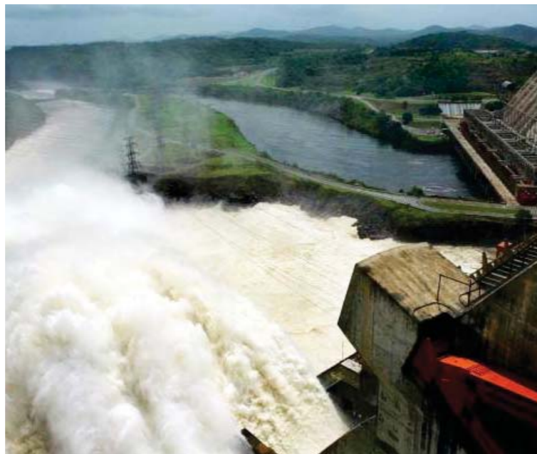
La central hidroeléctrica de Guri provee más de 63% de la energía eléctrica de Venezuela
