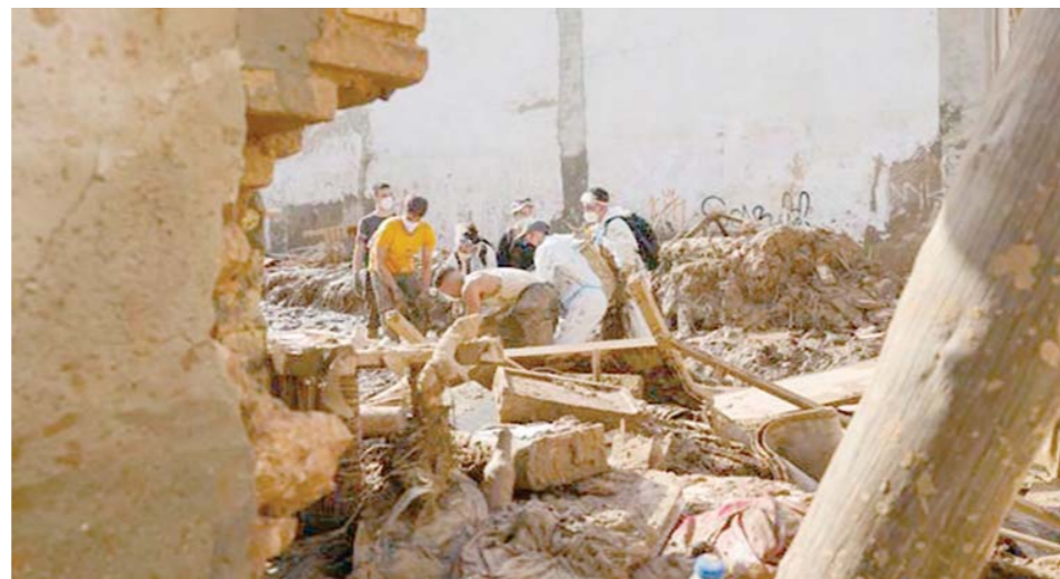
Voluntarios y vecinos trabajan para despejar una calle de Paiporta (Valencia)
